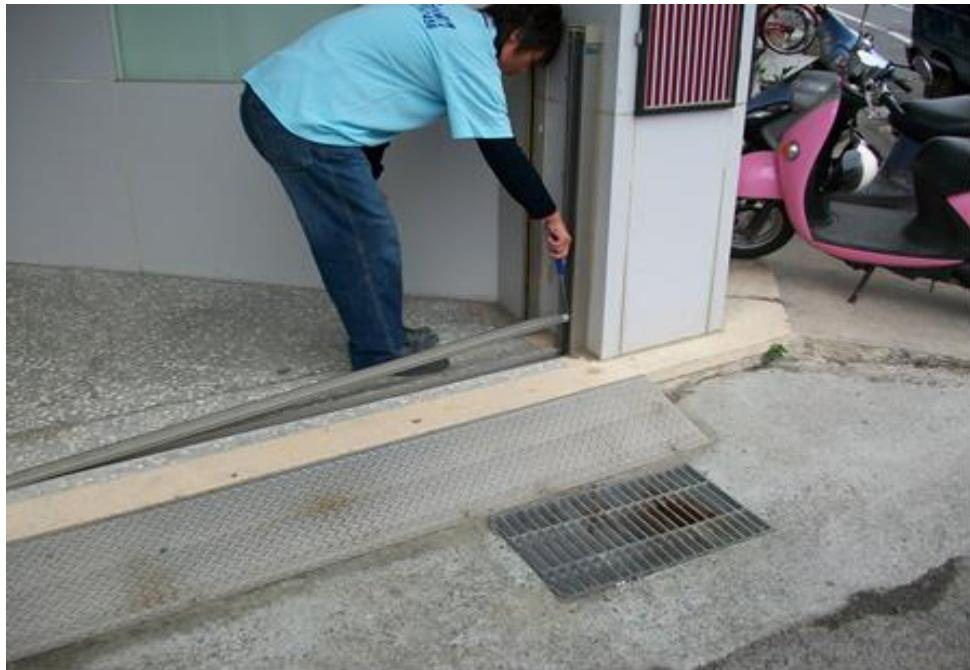
1. 掀起底槽蓋：先將底槽蓋板取下擺放於合適位置，清理底槽，並要完全乾淨無雜物，確保防水效果。
