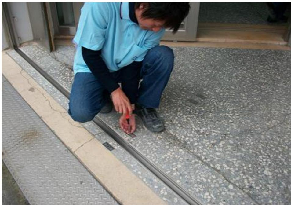
2. 卸下中柱, 斜支撐平頭螺絲：取下中柱地面預埋平頭螺絲並將中柱及斜支撐基底座依預埋位置固定鎖緊。
