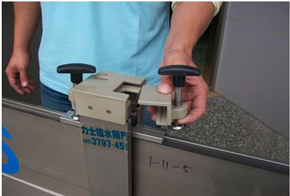
7. 中柱緊迫器向下鎖緊：將緊迫器螺絲上緊後，再將緊迫器組裝並且向下鎖緊。
