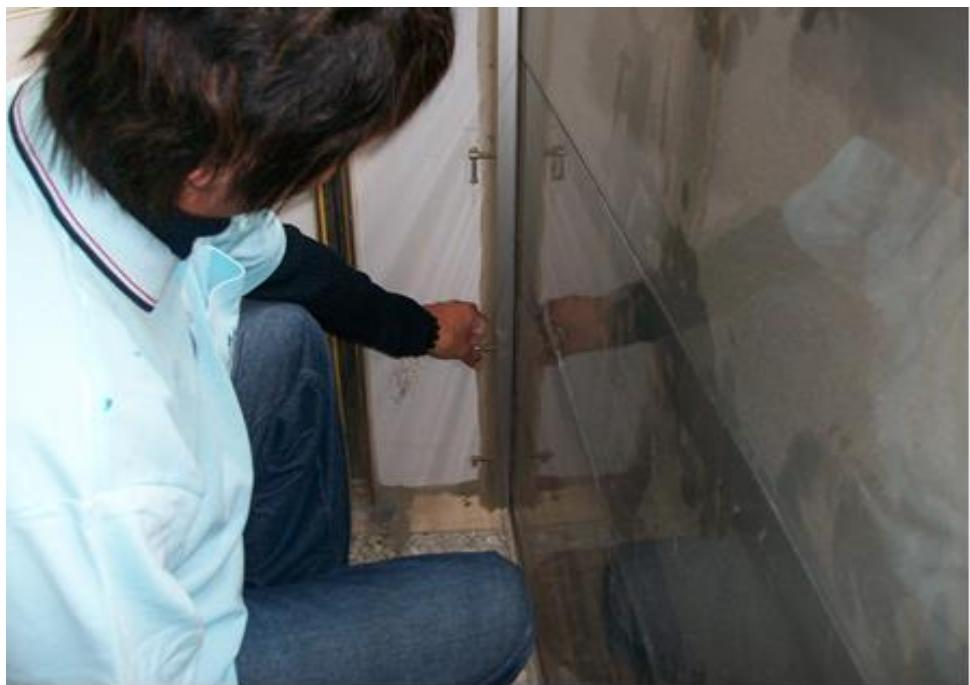
6. 邊柱螺栓鎖緊：將上述固定後，再將各迫緊器同時分段鎖緊。
