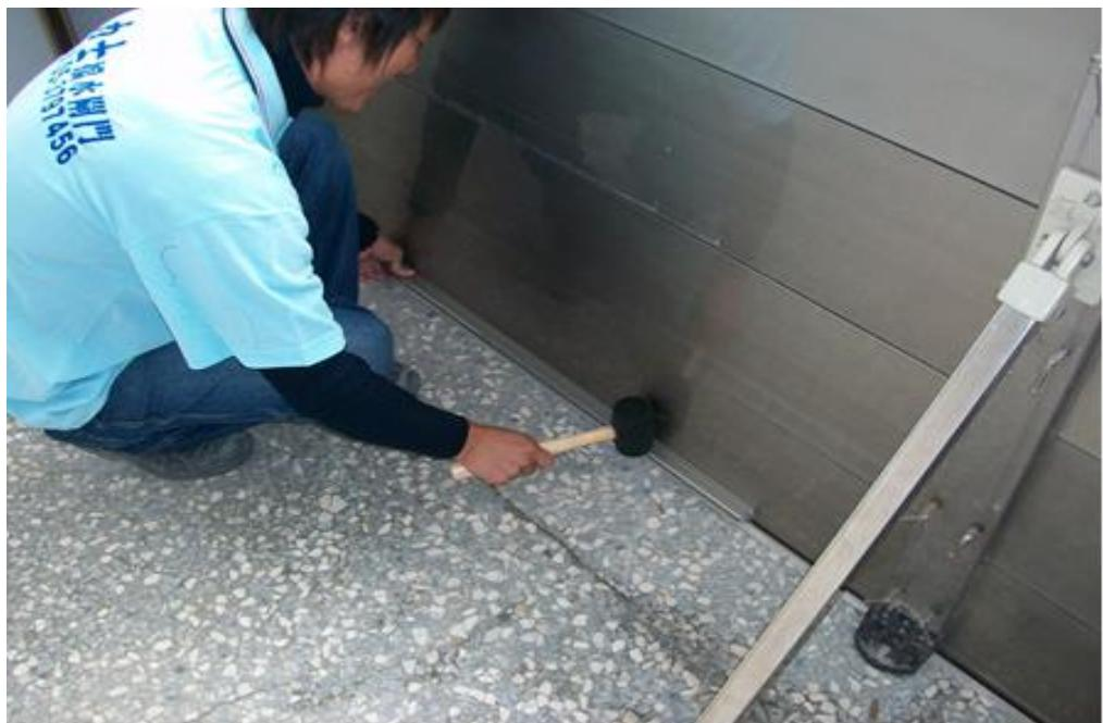
8. 三角壓條敲入：三角壓條插入底槽隙縫，加強防水功能。
