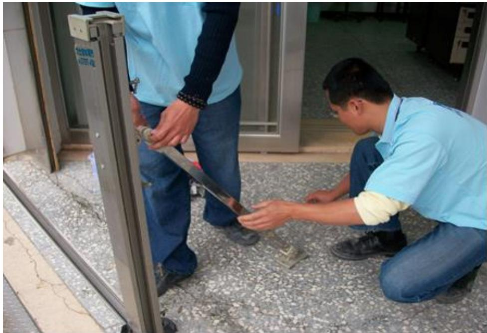
3. 裝設斜支撐：取下中柱預埋螺絲，置放所預置中柱底座並固定之，並稍微調整兩端邊柱壓迫器及迫緊螺絲。
