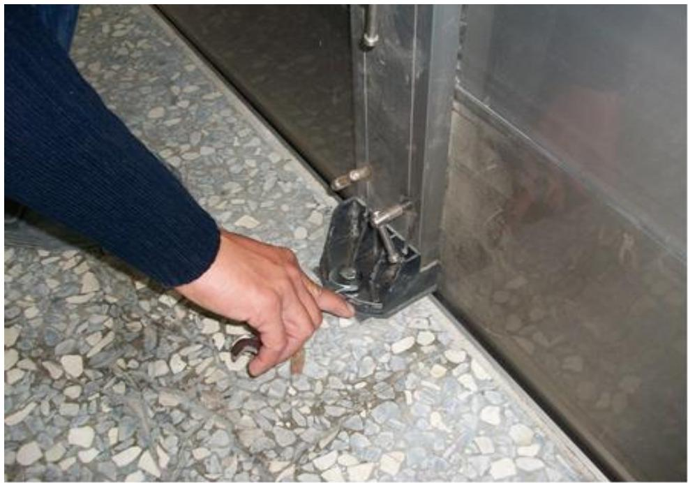
5. 將中柱螺絲鎖緊：將中柱及斜支撐基座依預埋位置以六角螺絲固定鎖緊。
